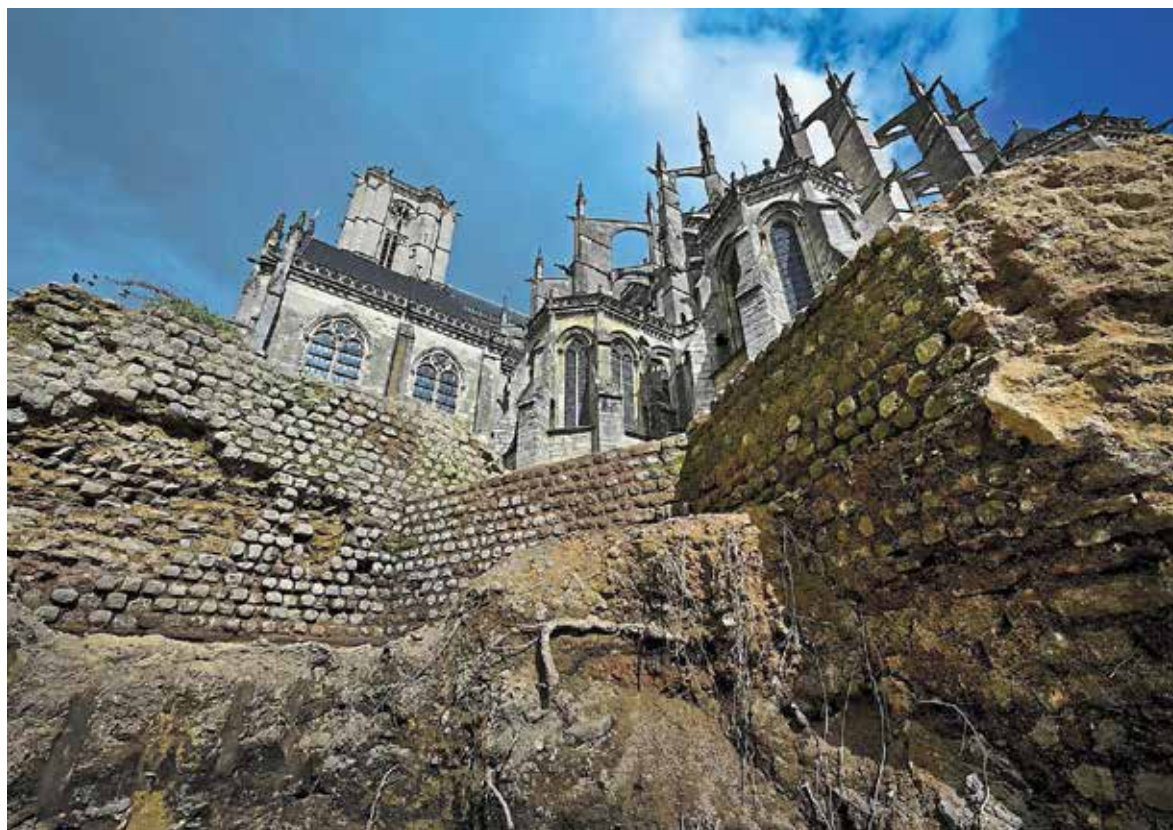
Le Mans mercredi matin. Depuis septembre, des tonnes de terre ont été déblayées, laissant apparaître de véritables trésors.
