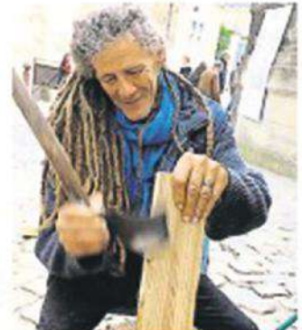
Coute en main, Pascal prépare des bardeaux de châtaignier fendu.
